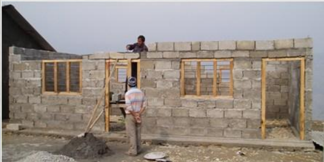
Bouwwerkers bezig met de laatste rij stenen.
