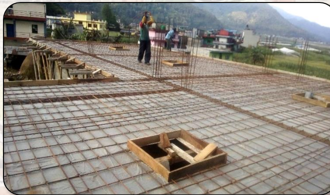
Op het dak van de lokalen kunnen we de bewapening duidelijk zien. De vierkante uitsparingen in het midden worden skylights. Deze zorgen straks voor extra licht.
